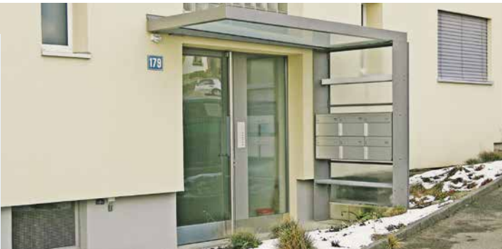
Hauseingang mit Vordach und integrierter Briefkastenanlage
