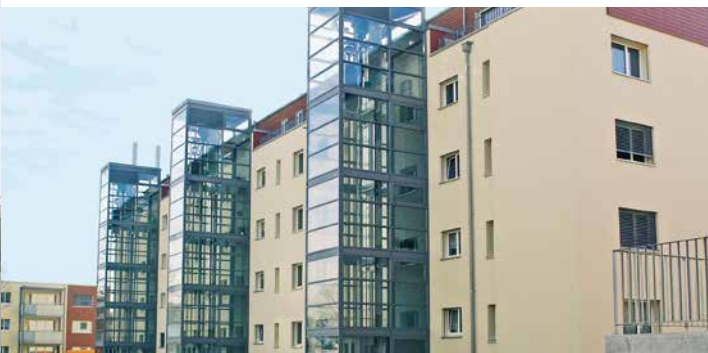
Aussenlifte bei einer Sanierung
