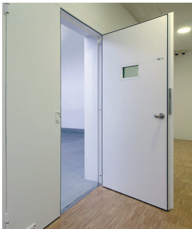
Sicherheitstüre zu einem Aufenthaltsraum
