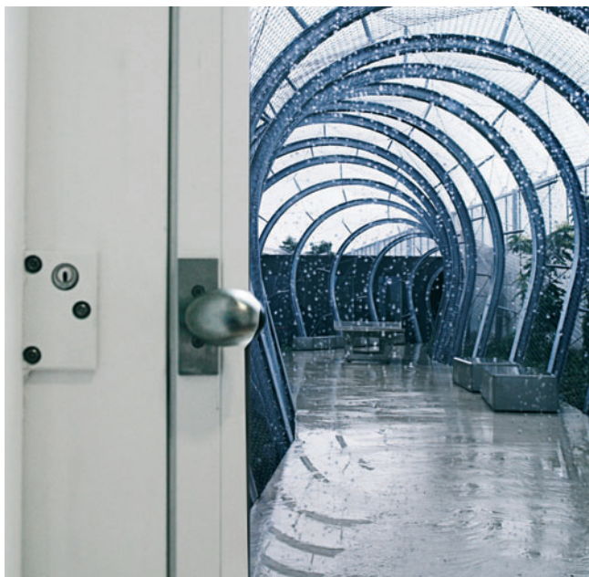
Sicherheitstüre zu einem Aussenbereich
