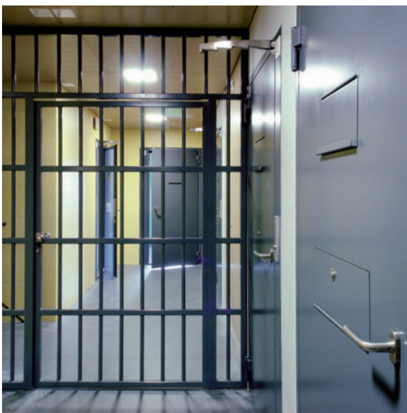
Korridor- und Treppenhausabschluss
