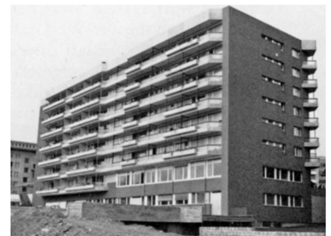
Das Schwamendinger Werkstattgebäude während der Fundierungsarbeiten für das 7-stöckige Wohn- und Geschäftshaus.
